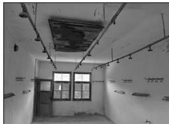
Document 3 : La salle de désinfection du block crématoire.
