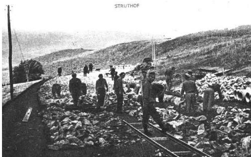
↑ Le travail d'aménagement de la route qui mène au camp du Struthof.
