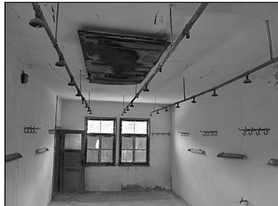
La salle de désinfection du block crématoire.
